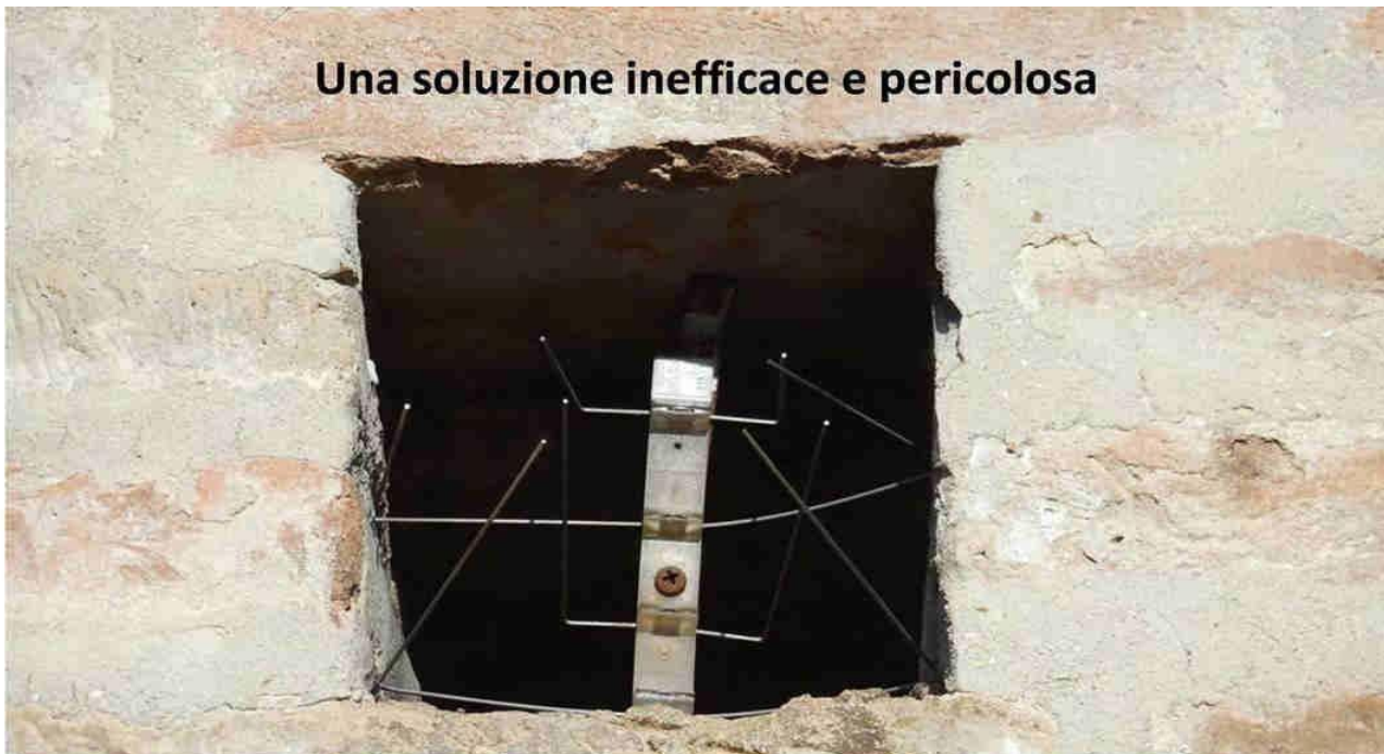
Foto 17 - Questa soluzione applicata sull'apertura di un edificio storico è inefficace e pericolosa per i piccoli uccelli insettivori e per i chiroteri, che potrebbero rimanere infilzati sulle punte.
